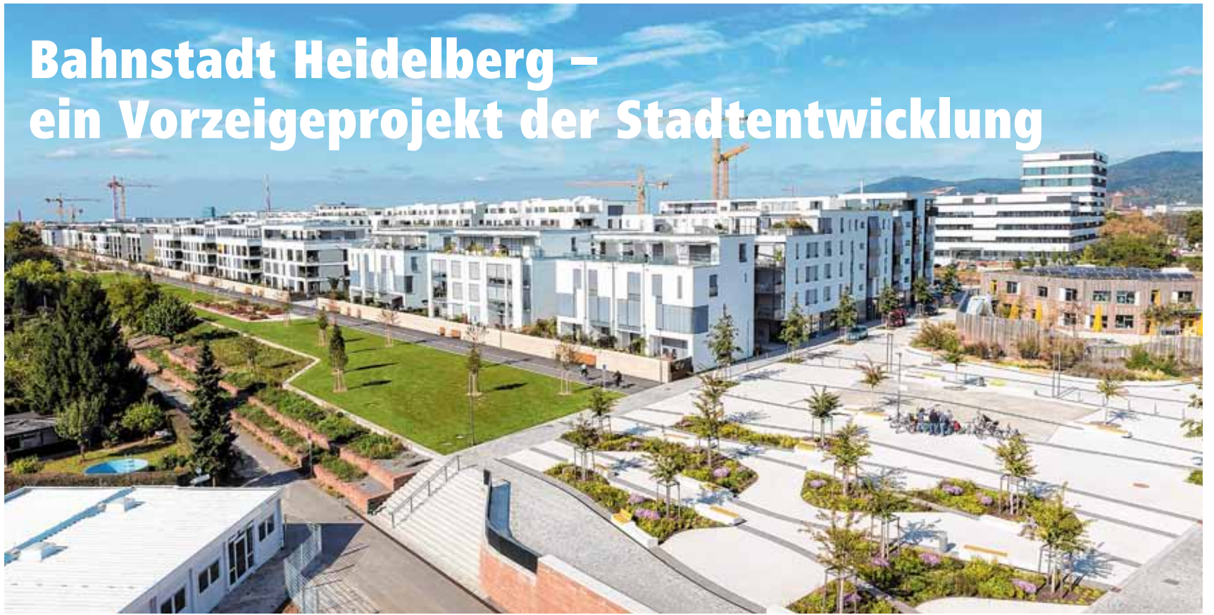
Bahnstadt mit Wohnbebauung, Schwetzingter Terrasse, Kita und Skylabs
