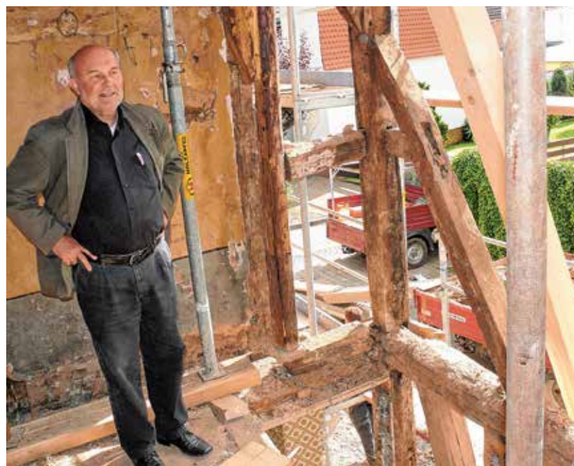
Architekt Horst Sieland, ebenfalls Mitglied der Gruppe, während der Sanierungsarbeiten im August 2010
