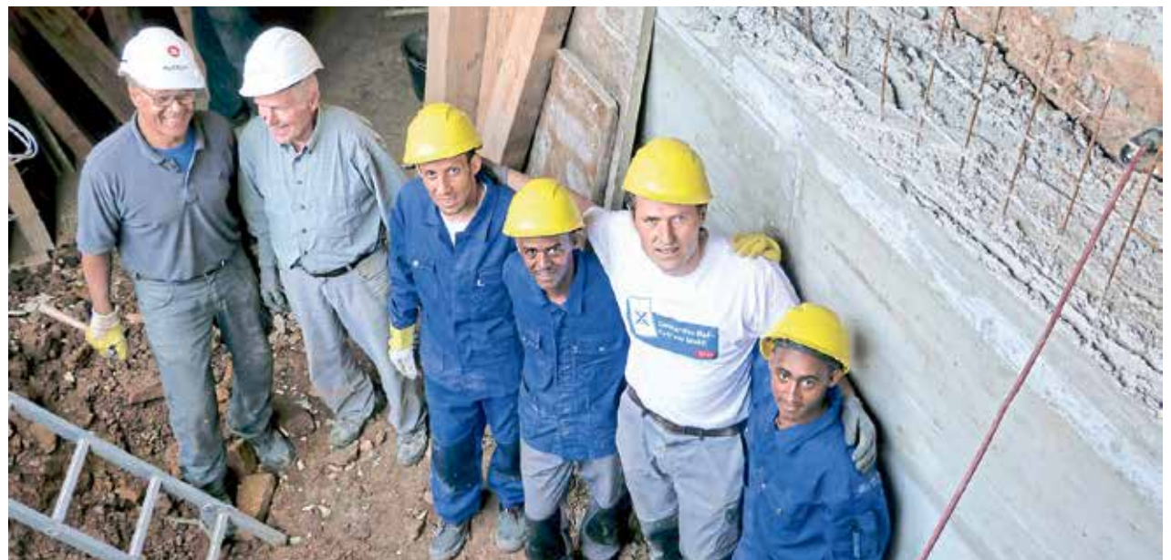
Praktikanten bei der Renovierung eines ehemaligen Gasthofs (König von Preußen) in Helsa
