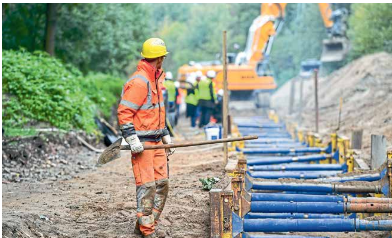
Verlegung des ersten Abschnitts der zweiten Riedleitung
